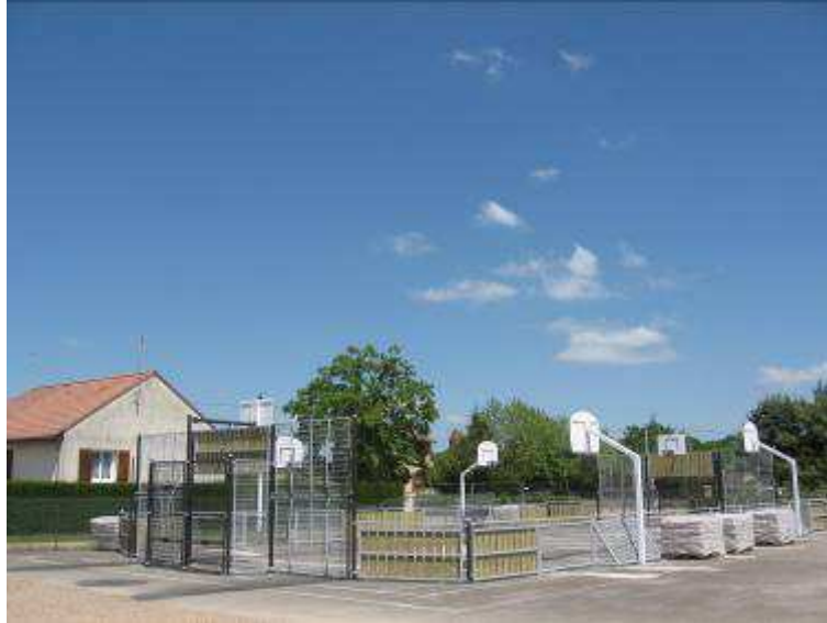
Terrain multi-sport pendant les travaux
